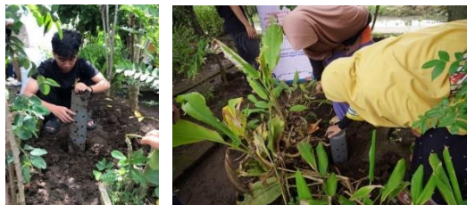
Gambar 8. Pemasangan Pipa Biopori
