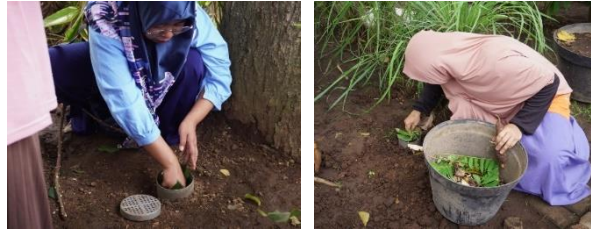
Gambar 9. Pengisian Bahan Organik ke dalam Biopori
