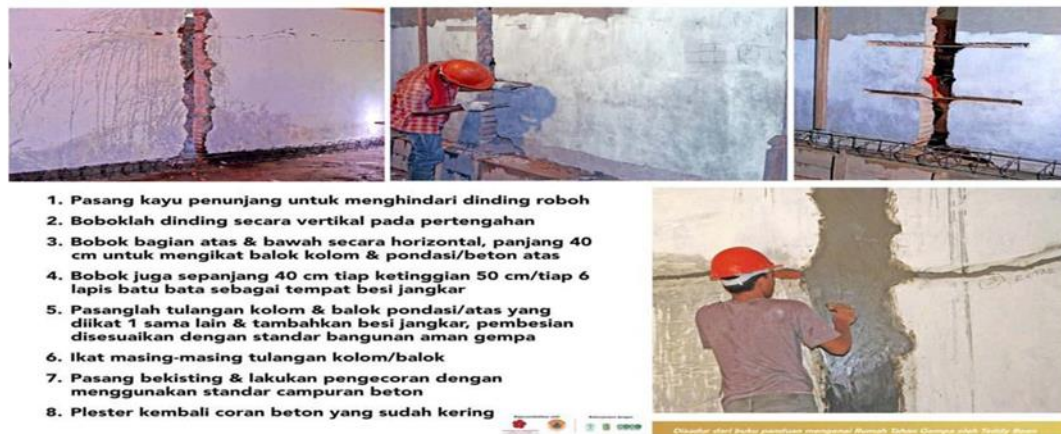
Gambar 15. Perbaikan Dinding Retak Lebih Dari 9m 2
