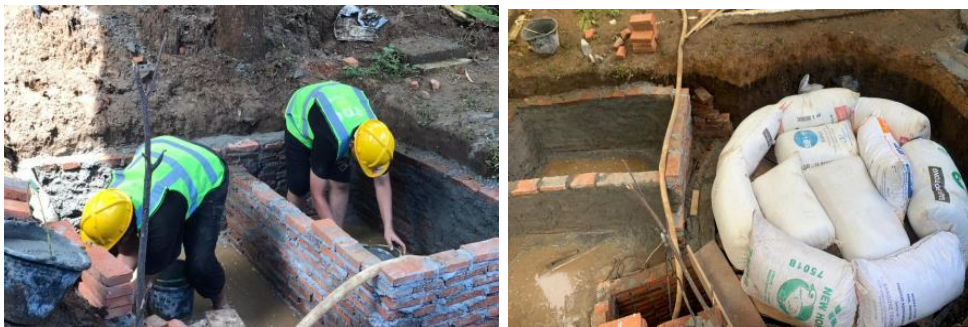
Gambar 7. Proses Pembuatan Instalasi Biodigester
