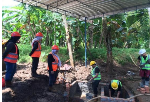
Gambar 8. Pengawasan Pembuatan Digester
