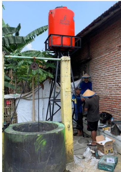
Gambar 3. Pemasangan Toren Air
