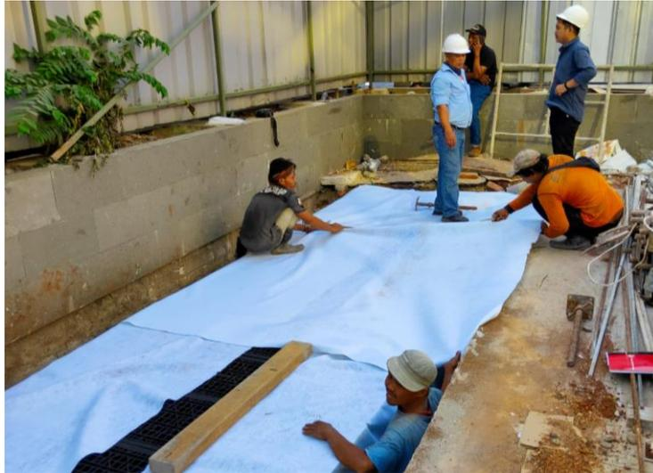
Gambar 1. Implementasi Pemasangan Geotextile Non Woven
